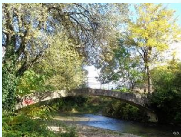
Passerelle de Laye sur la Véore .
